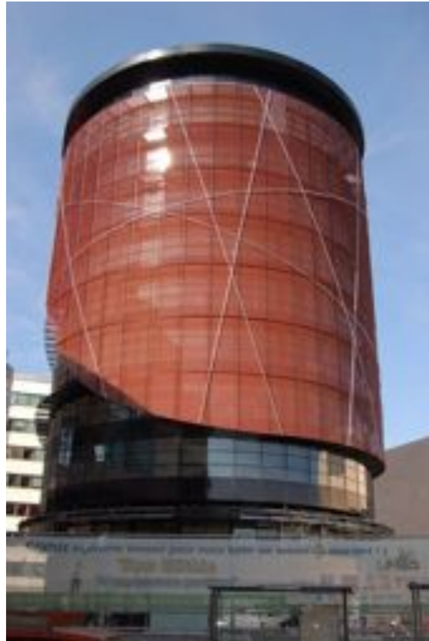
Tour Elithis à Dijon Arte Charpentier, Architectes 2008 5000 m2 Bâtiment BEPOS
