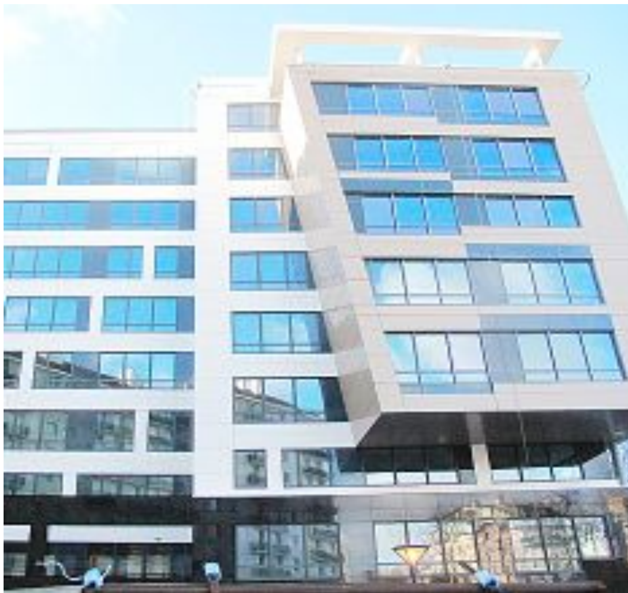
Montrouge, FAIRWAY Haour arch. 16 000 m 2 pour 1 300 salariés double certification Minergie et BBC + associée à une démarche HQE
