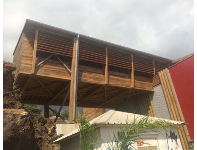
La passerelle, photo de l'entrée.
