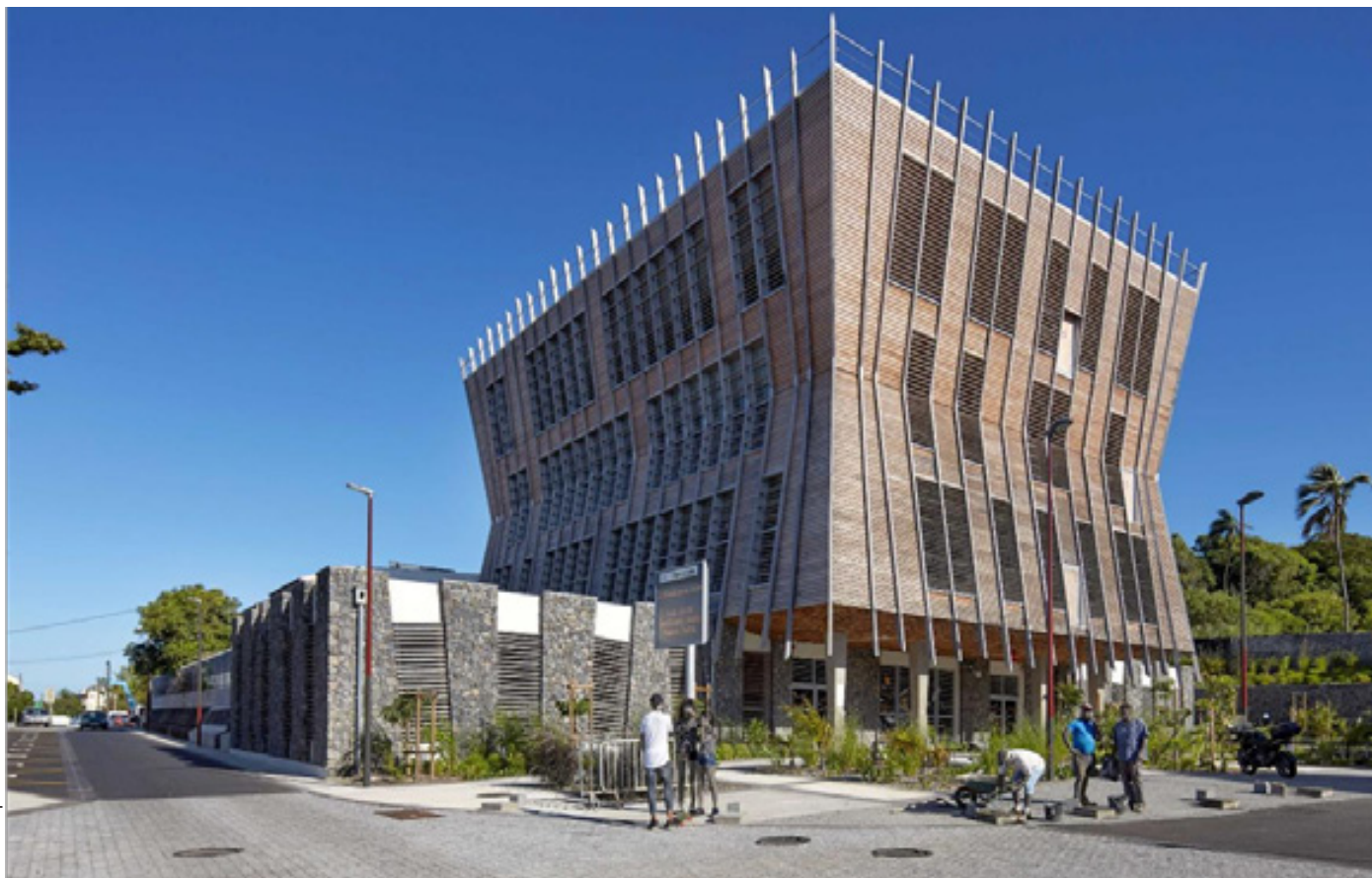
Parvis et entrée de la médiathèque. Le fagot de vétiver posé sur un bloc de basalte
